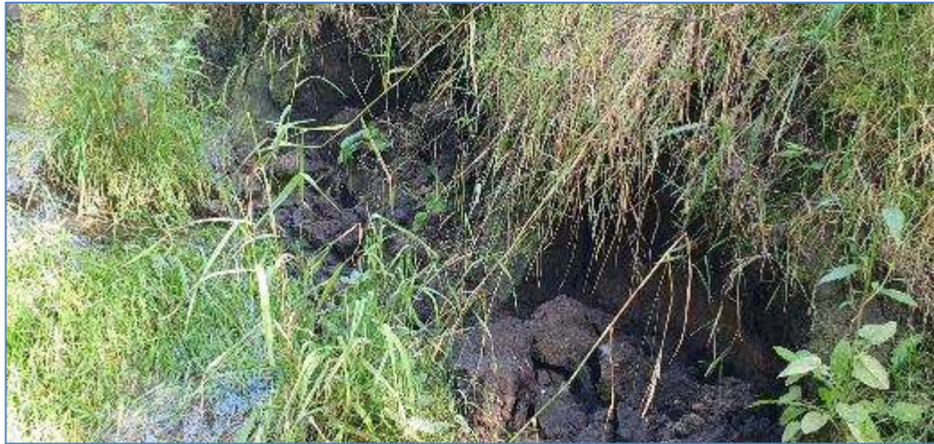
Fabjerg Bæk strækning A er på den nedre del hvor brinken er eroderet/skredet voldsomt sammen pga. kronhjorte færdsel.
